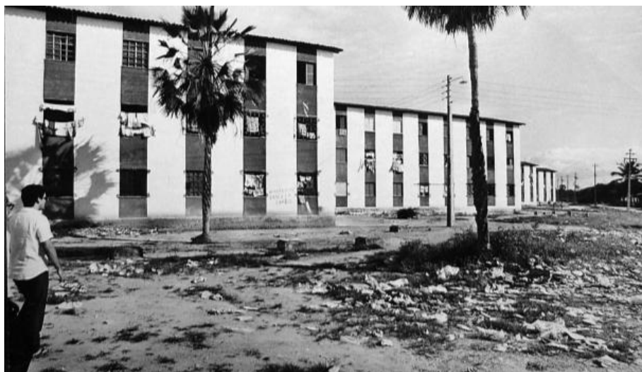
Figura 15 – Conjunto Novo Mondubim, construído pelo BNH em Fortaleza
