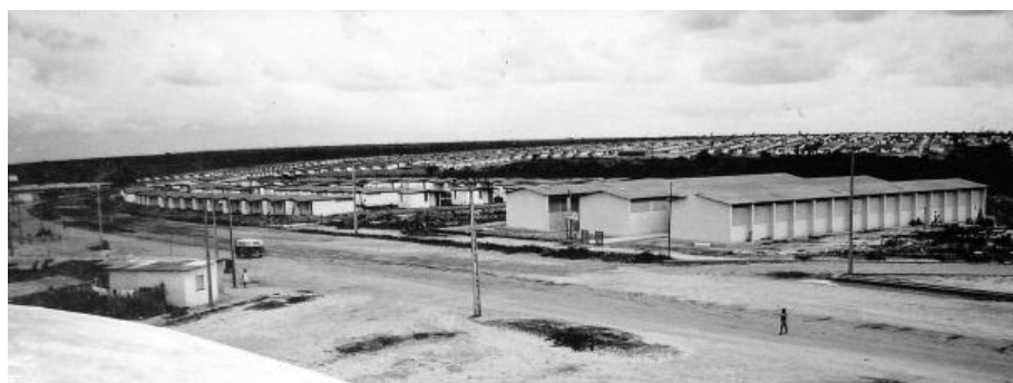
Figura 47 – Conjunto habitacional Marechal Rondon
