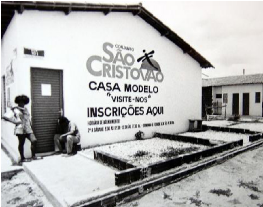
Figura 34 – ‘Casa Modelo’ do Conjunto Habitacional São Cristóvão
