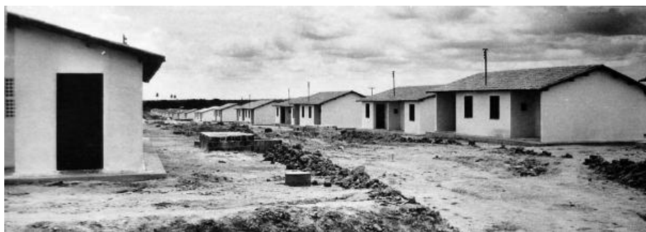
Figura 50 – Conjunto habitacional Timbó
