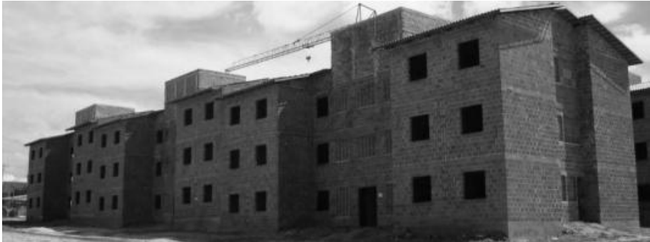
Figura 61 – Unidades habitacionais verticalizadas do conjunto Rosalina
