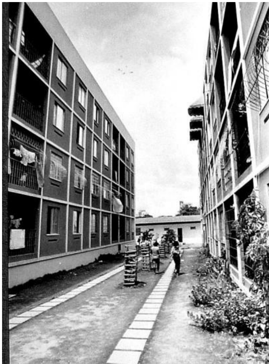
Figura 30 – Conjunto Lago Azul, construído pelo Inocoop em Fortaleza
