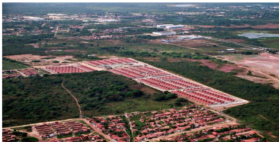
Figura 38 – Vista aérea do Conjunto Maria Tomásia
