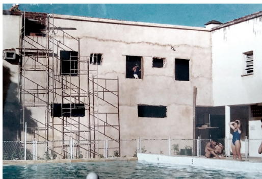
Figura 135 – Obras de execução de novos banheiros do Bloco H.
