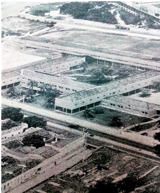
Figura 75 – Vista aérea da escola após a construção do bloco 2 (final década de 1960).
