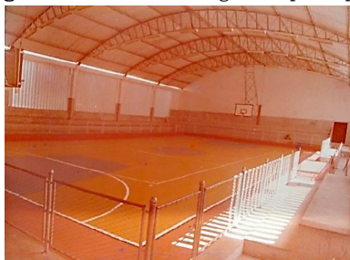
Figura 122 – Reforma do ginásio principal
