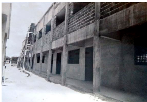
Figura 113 – Execução do bloco da Construção Civil
