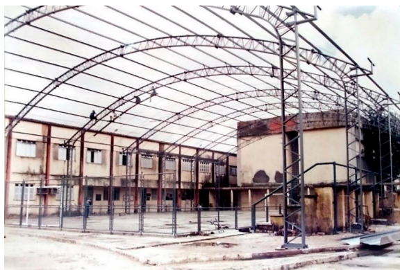
Figura 136 – Reforma da quadra com execução de cobertura
