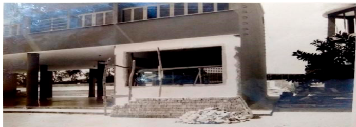
Figura 111 – Fechamento do pilotis do bloco 2 (lado poente).
