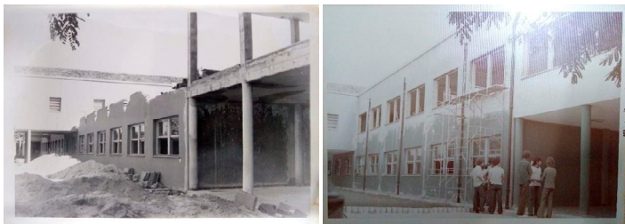
Figura 109 – Ampliação da fachada do bloco H – vistas interna e externa
