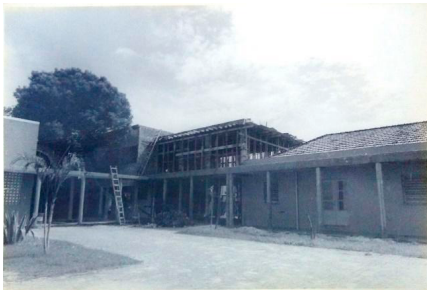
Figura 110 – Fachada interna do bloco H
