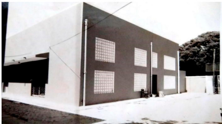
Figura 116 – Vista Norte/Leste do novo almoxarifado.
