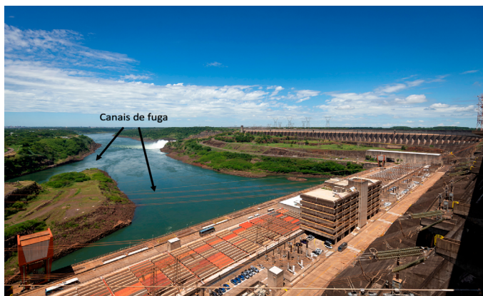
Figura 90 - Canais de fuga da UHE Itaipu
