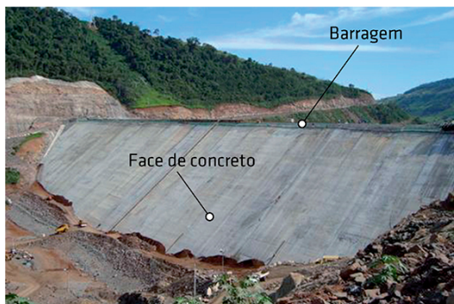
Figura 81 - Barragem de enrocamento com face de concreto
