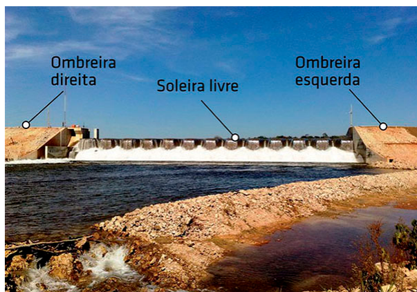
Figura 85 - Vertedouro de soleira livre. PCH Bocaiuva
