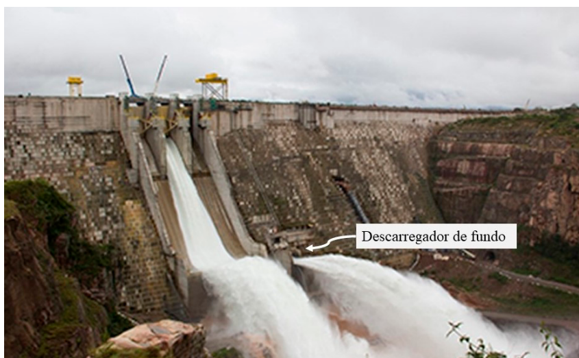
Figura 87 -Hidrelétrica Laúca - foto exibindo descarregador de fundo.
