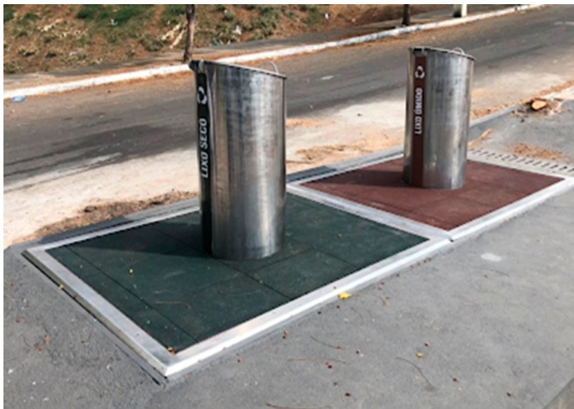
Figura 9 – Lixeiras subterrâneas no município de Sobral
